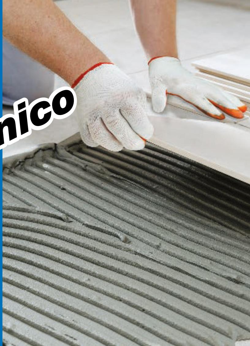
de Investigación y Desarrollo de MAPEI. **Kerabond Porcelánico**, mezclado con agua, es un adhesivo de excelente trabajabilidad y alta adherencia que puedes ser aplicado en pisos y muros.
