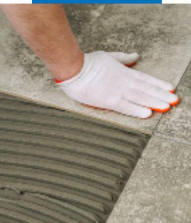
**Coloque las piezas sobre el adhesivo presionando mientras mueve la pieza en sentido perpendicular al adhesivo**
